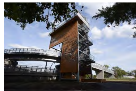
19. Passerelle piétons-vélos et point de repère. Longueuil.
