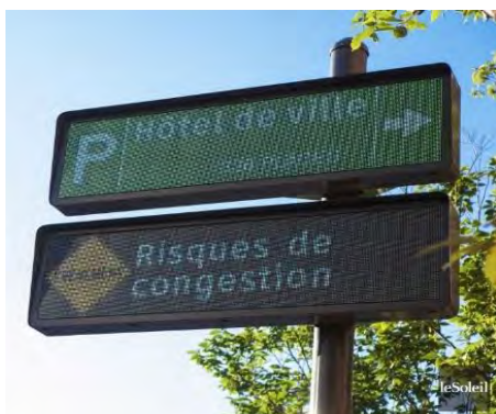
87. Jalonnement dynamique. Québec.
