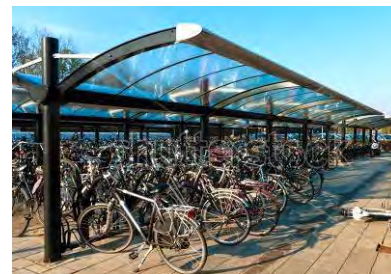
25. Exemple de stationnement couvert pour vélos. Pays-Bas.
