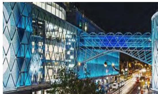
72. Passerelle au centre commercial Beaugrenelle, Paris.
