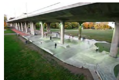
67. Skatepark sous un viaduct, Stockholm.
