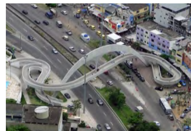
26. Passerelle interquartiers. Rio de Janeiro.
