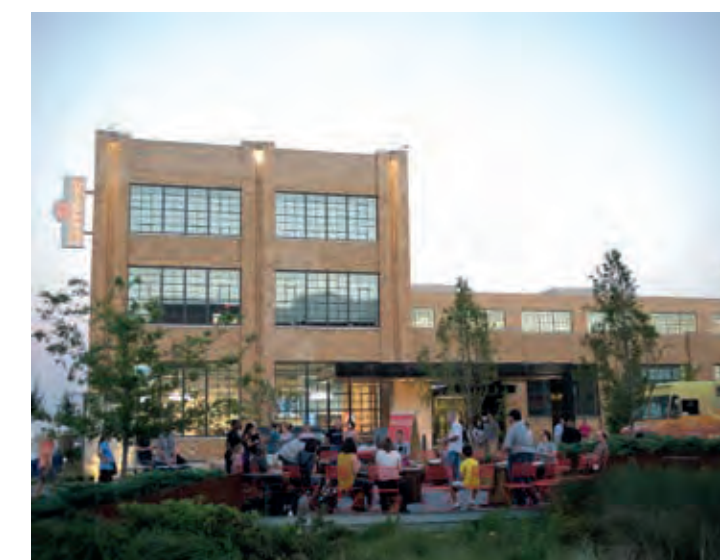
BÂTIMENT DE 1948 RÉHABILITÉ AVEC CERTIFICATION LEED Source : HOK
