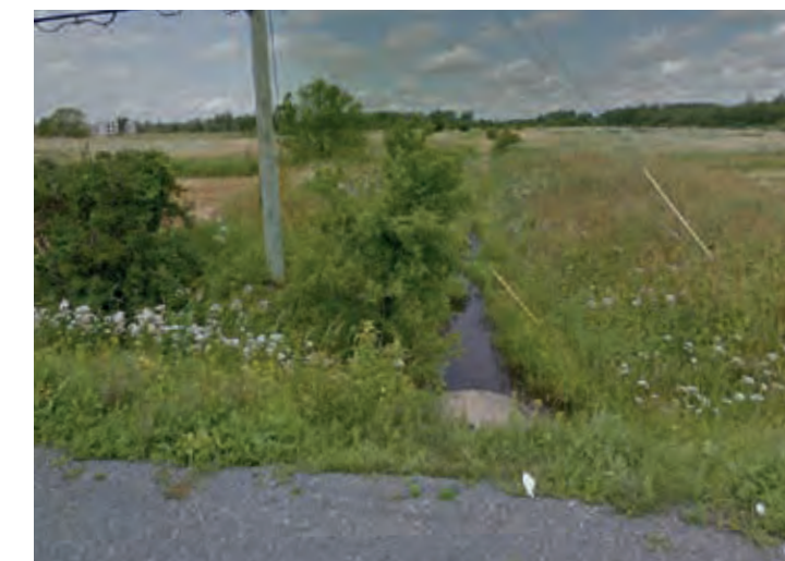
RUISSEAU MASSÉ À SON INTERSECTION AVEC LE CHEMIN DE LA SAVANE Source : Ville de Longueuil
