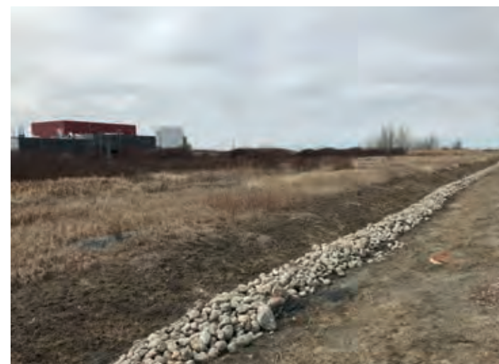
FOSSÉ LE LONG DE LA RUE JOHN-MOLSON Source : Ville de Longueuil
