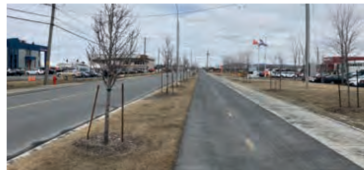
PISTE CYCLABLE ET TROTTOIR SUR LA RTE DE L'AÉROPORT Source : Ville de Longueuil
